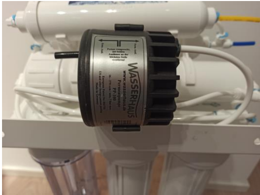
Abb.1: Permeatpumpe zur Steigerung des Wirkungsgrades bei der Wasserfiltration.
